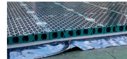
“Fahrbelag” mit Retentions-Spacer RSX 65
