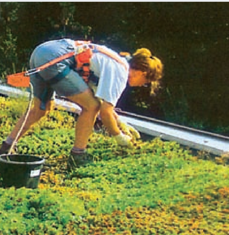
Een voldoende hoge borstwering: geen extra maatregelen nodig!
